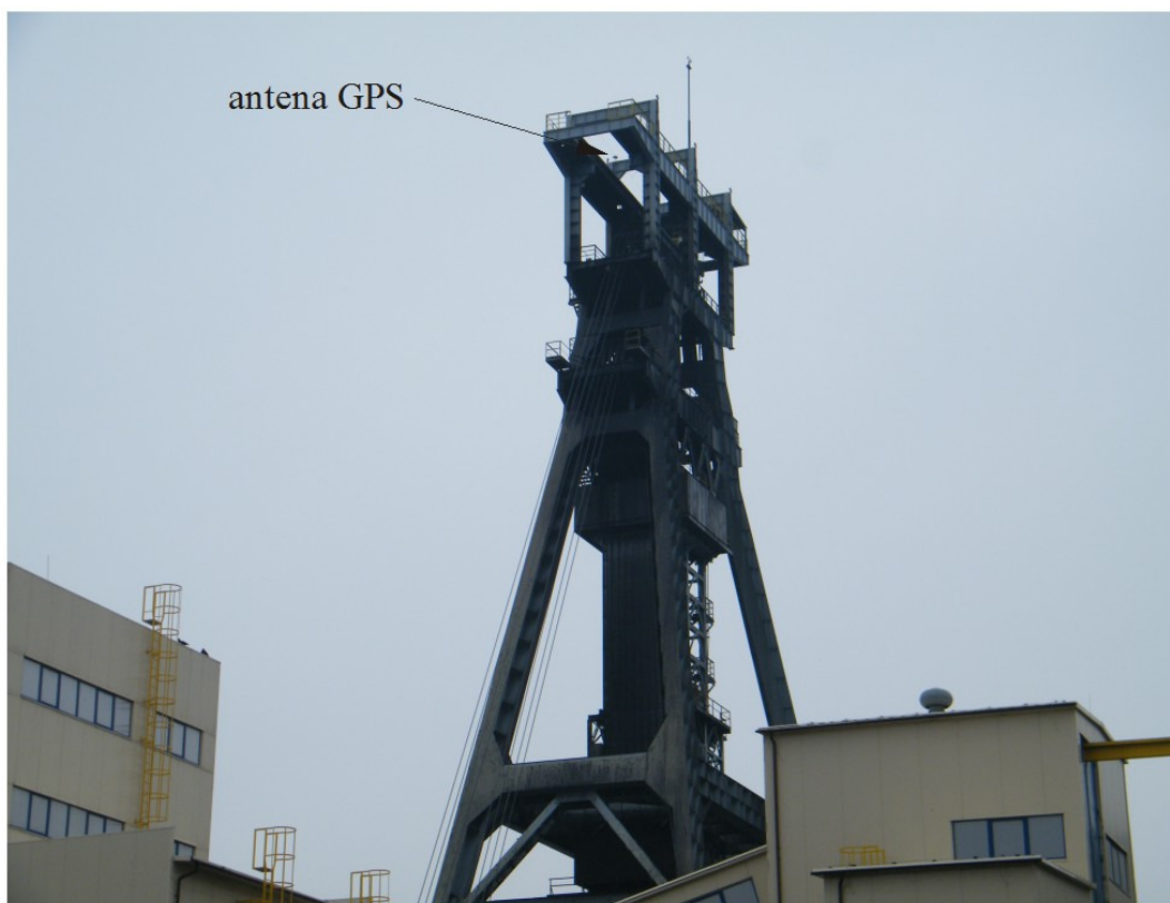
Rys. 3. Widok ogólny wieży szybu S 1.3, kopalni LW „Bogdanka” Fig. 3. General view of the tower shaft S 1.3, mine LW „Bogdanka”
